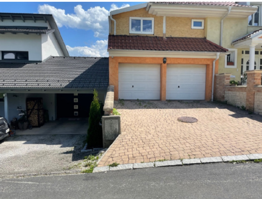
12: Bebauungssituation entlang der südlich gelegenen Grundstücke entlang der Erschließung am Hauerschlüssel; das Gebäude im rechten Bildteil verfügt über eine offensichtlich im Bau befindliche nachträgliche Aufstockung des an der seitlichen Grundstücksgrenze befindlichen Nebengebäudes
