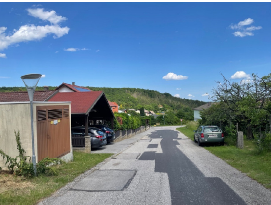
22: Joh. Földesgasse mit Blick Richtung Osten; erkennbar ist der einseitig ausgeführte Gehweg entlang der Verkehrserschließung; das Trafogebäude im Vordergrund sowie das dahinterliegende, offensichtlich nachträglich zur Erschließung hin verlängerte Nebengebäude, ausgeführt als Carport mit Satteldach, grenzt an die Straßenfluchtlinie
