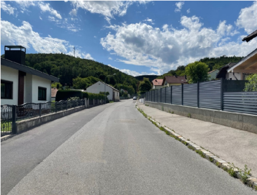
23: Gartengasse mit Blick Richtung Westen; die Grundstücke rechts der Erschließung werden in den Geltungsbereich aufgenommen
