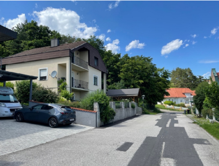
09: das Gebäude im linken Bereich entlang Bihrleiten verfügt über zwei voll wirksame Geschosse (KG und EG) und einem ausgebauten Dachgeschoss; der Gebäudefirst ist orthogonal zur vorderen Grundstücksgrenze gerichtet;
