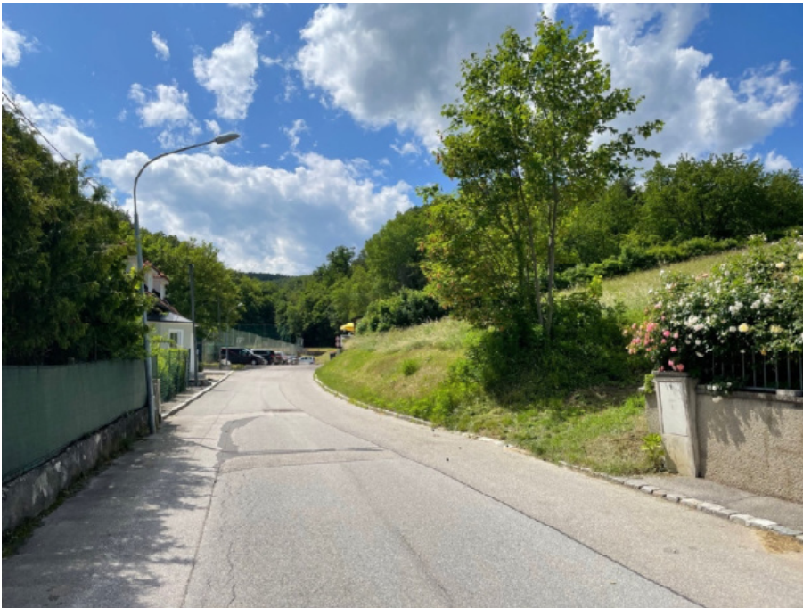
01: Gartengasse mit Blickrichtung Tennisplatz; Grundstücke rechts der Straße befinden sich innerhalb des neu festgelegten Geltungsbereichs; das unbebaute Grundstück fällt, wie sämtliche Grundstücke entlang der Gartengasse, Richtung Süden hin ab; im südlichen Grundstücksbereich ist eine ausgeprägte Böschung erkennbar
