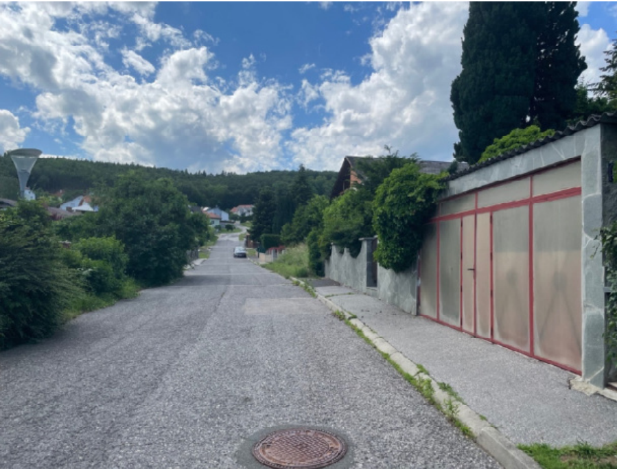
17: Östlicher Teilbereich von Am Hauerschlüssel mit Blick Richtung Westen mit plateauähnlicher Geländeausprägung; in diesem Bereich sind hohe Stützmauern bzw. massive Einfriedungen und Nebengebäude vorhanden, die bis an die Straßenfluchtlinie reichen
