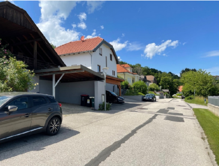
07: Bihrlaiten mit Blick Richtung Nord-Nordwest; die Bestandsgebäude folgen im Grunde einer gemeinsamen vorderen Baulinie; Nebengebäude, ausgeführt als Carports, reichen hier bis zur angrenzenden Verkehrsfläche
