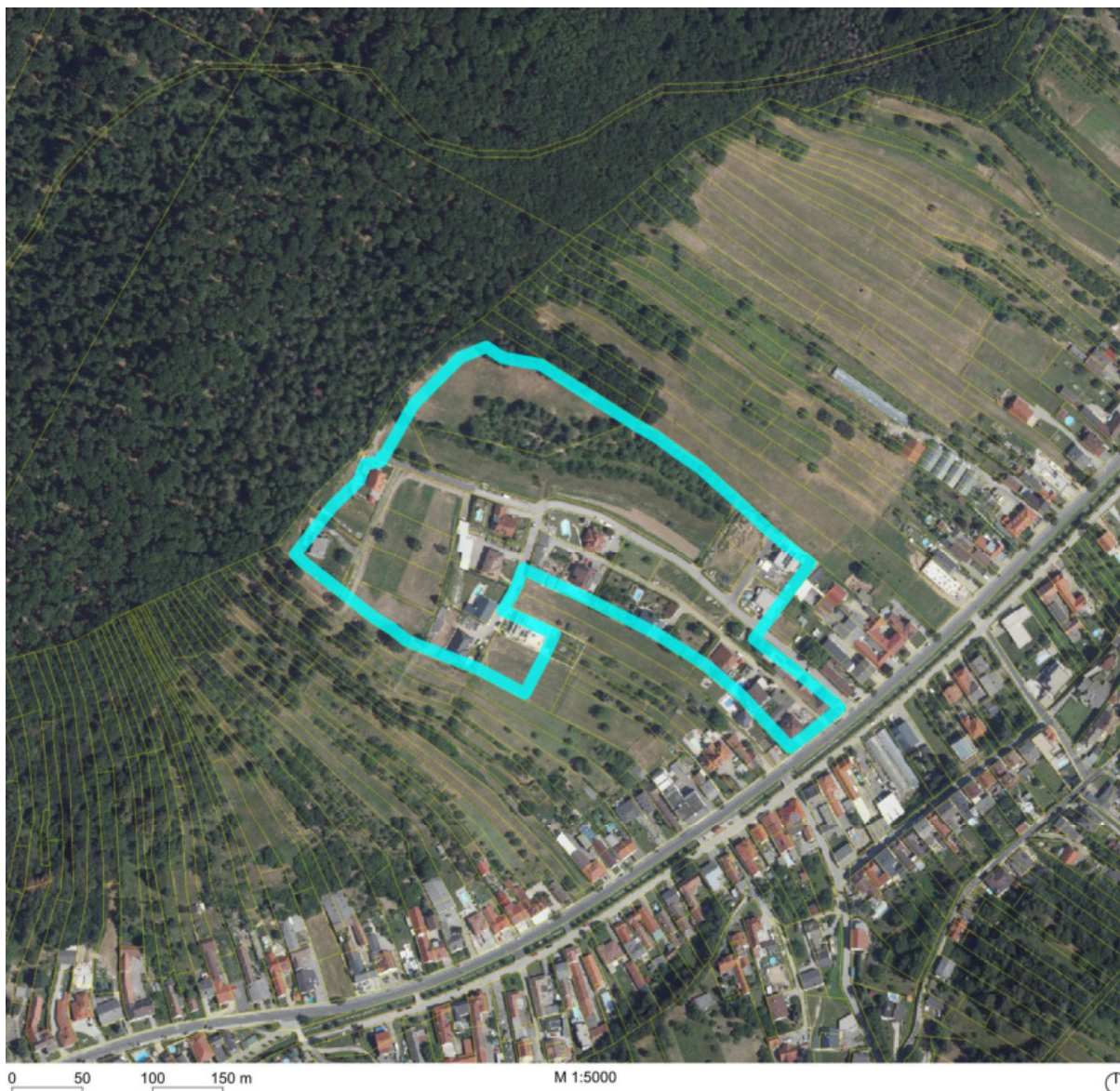
Abbildung 3: Darstellung des Umfelds des Projektgebiets auf Basis DKM 10/2025 und Orthofoto (Quelle: BEV, GeoDaten Burgenland, 2026, eigene Darstellung)
