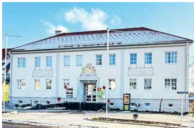
Auf dem Rathausdach wird eine Photovoltaikanlage angebracht
