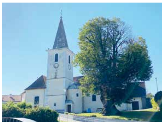
Die Barbarakirche wird generalsaniert, ebenso die Orgel
