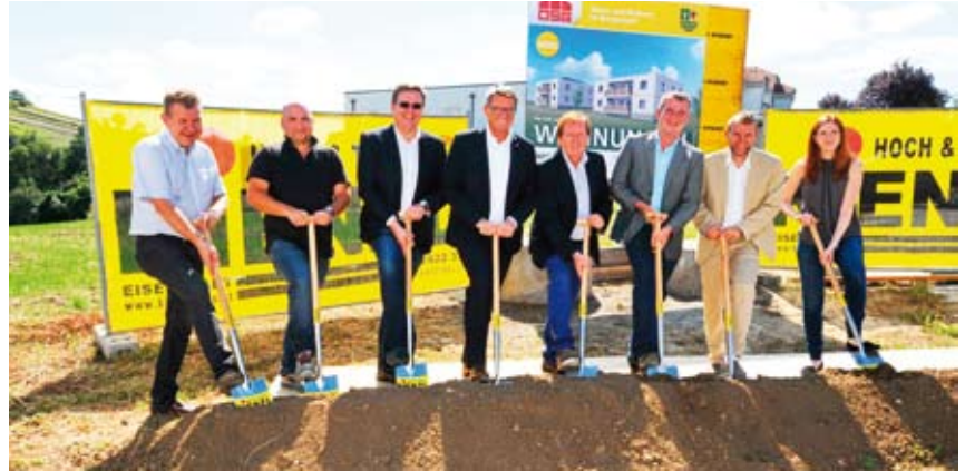
Spatenstich für sechs neue Wohnungen
