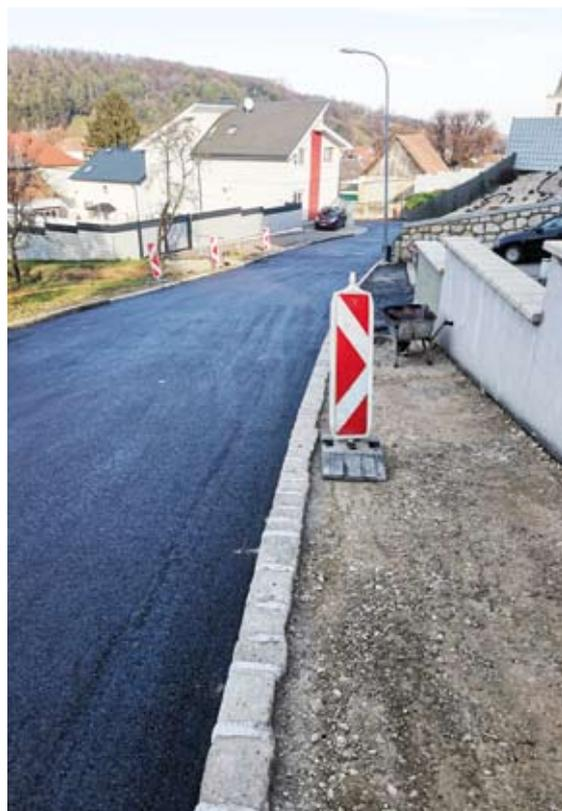
Ein großes Sanierungsprojekt wird in der Höhenstraße und Oberen Höhenstraße durchgeführt. Dieses Jahr wurden bereits die Wasser- und Gasleitung erneuert. Weiters geplant sind die komplette Erneuerung der Fahrbahn sowie Optimierung der Oberflächenentwässerung.
