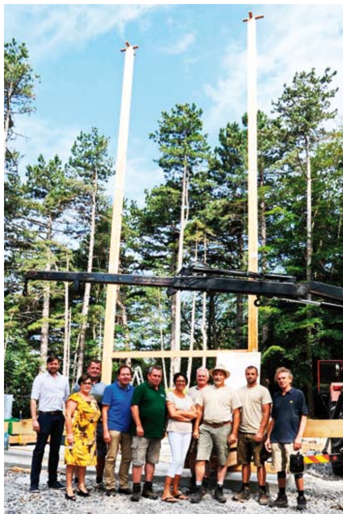
Bürgermeister Bernhard Karnthaler und Bürgermeister Matthias Weghofer besichtigen die Baustelle der Aussichtsplattform
