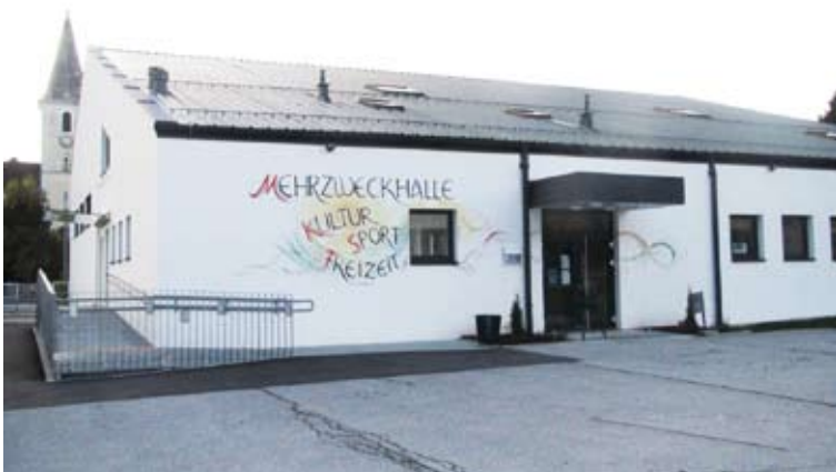
Thermische Sanierung der Mehrzweckhalle wurde 2016 abgeschlossen: neue Fenster und Türen, neuer Sonnenschutz, neue energiesparende Fassade, barrierefreier Zugang, neues Fassadengemälde
