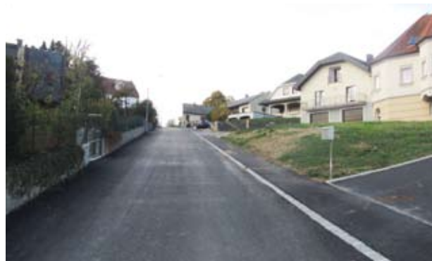
Asphaltierung der Oberen Lindengasse.
