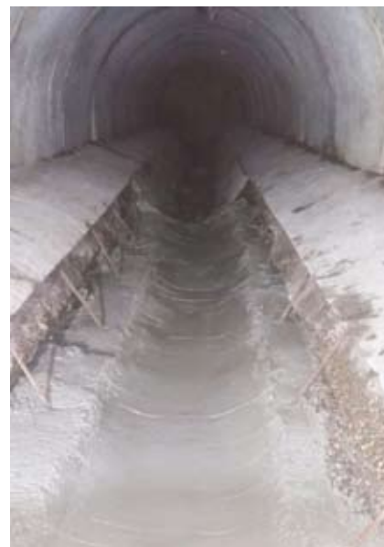
Weitere Sanierung des Edlesbaches vom Einlauf im Graben bis zur Frohsdorferstraße. Bürgermeister Matthias Weghofer konnte zwei Drittel Förderung von der Bgld. Landesregierung für die Marktgemeinde erreichen.
