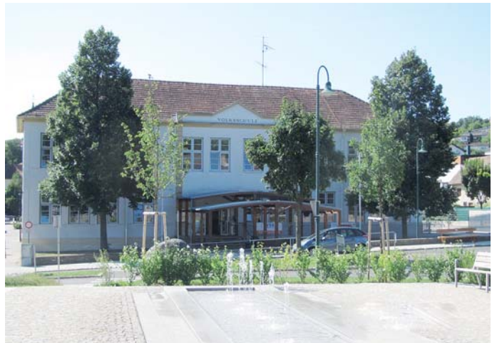
Sanierung der Volksschule – die Klassenräume wurden neu adaptiert, Brandabschnitte geschaffen und der Eingang wurde barrierefrei gestaltet
