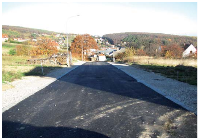
Asphaltierung und Kanalisierung der Oberen Lindengasse – im Bereich der Neuaufschliessung wurde der Kanal verlegt und erstmalig neu asphaltiert. Alle Kosten wurden anteilmäßig zu 100 Prozent von den Grundstücksbesitzern bezahlt.
