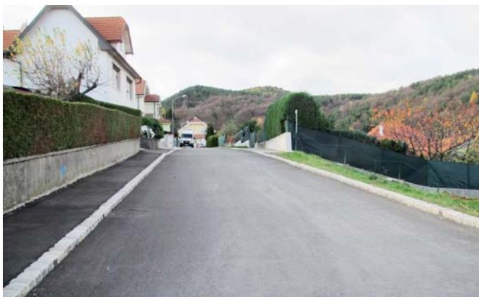
Asphaltierung der Höhenstraße – für die Anrainer entstanden, im Gegensatz zu anderen Gemeinden, keine Kosten
