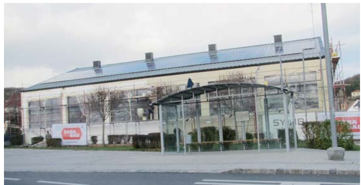
Sanierung der Mehrzweckhalle – neue energiesparende Fenster wurden eingebaut und eine Vollwärmeschutzfassade angebracht
