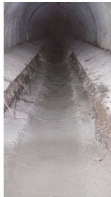
Bachabdeckung hinter der Mehrzweckhalle wurde erneuert
