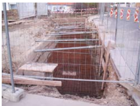
Bachabdeckung hinter der Mehrzweckhalle wurde erneuert
