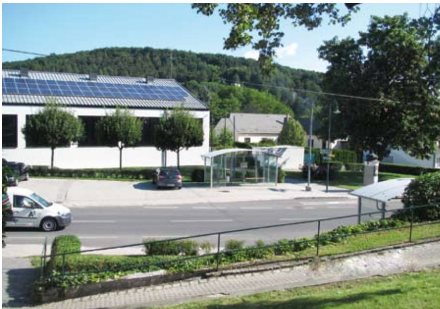
Bereich hinter der Mehrzweckhalle und Auffahrt zur alten Pfarrkirche wird saniert
