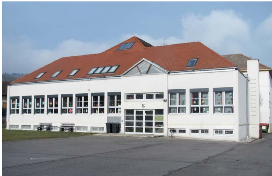
Die Volksschule Wiesen erfährt eine Generalsanierung
