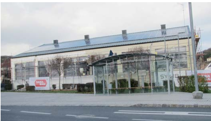
Sanierung der Mehrzweckhalle
