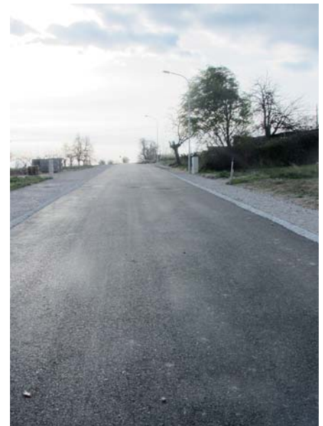
Asphaltierung Obere Lindengasse
