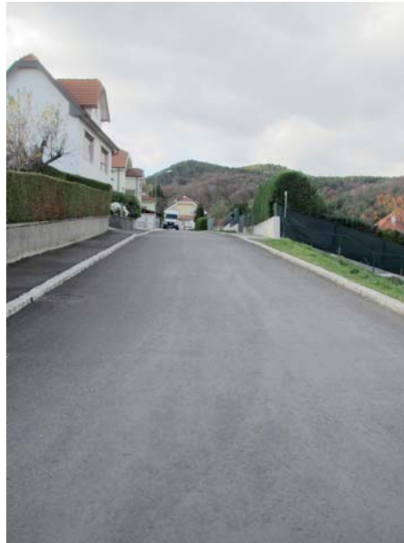
Asphaltierung Obere Höhenstraße
