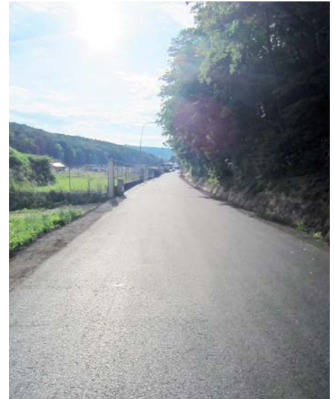
Asphaltierung der Schöllingstraße
