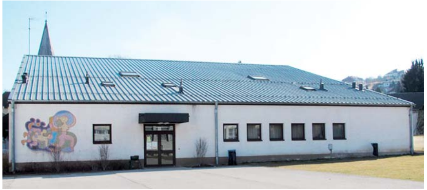
Mehrzweckhalle wird thermisch saniert und bekommt eine neue energiesparende Fassade
