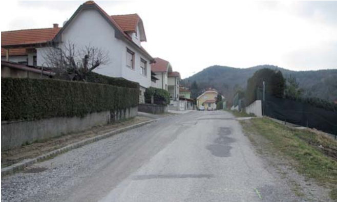
Obere Höhenstraße wird teilweise neu asphaltiert
