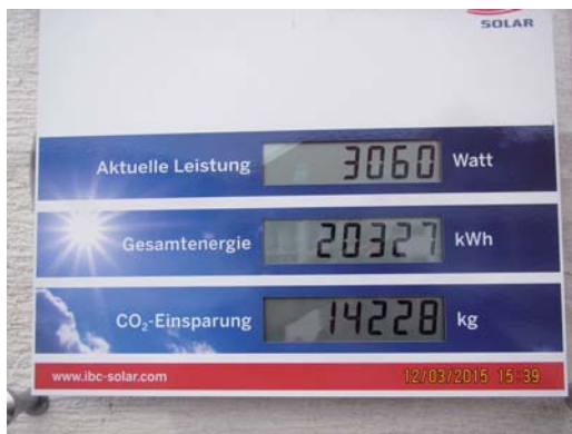
Der Zähler an der Mehrzweckhalle zeigt genau den von der Photovoltaikanlage erzeugten Strom und die CO 2 Einsparung an
