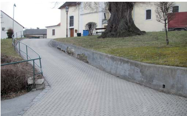
Auffahrt zur alten Pfarrkirche wird saniert
