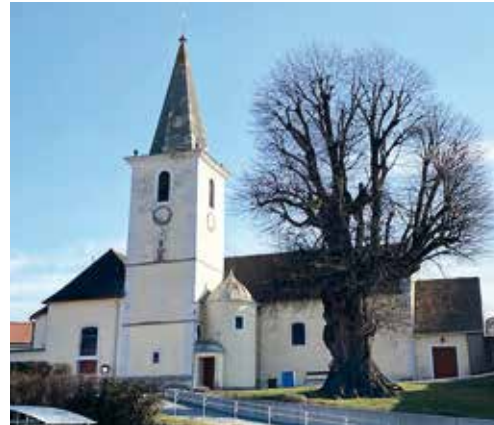
Barbarakirche wird generalsaniert
